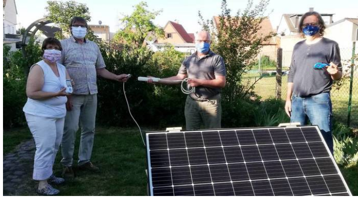
Mini-Fotovoltaik-Anlage zum Eigenverbrauch: Die Grünen Ilka Simon, Manfred Simon, Horst Winter und Cliff Hollmann (von links) begutachten eine Installation mit bestem solarem Energie-Ertrag. Foto: privat
