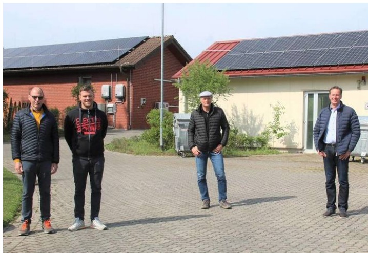
Fototermin an der Kläranlage in Klein-Krotzenburg, von links: Walter und Thomas Blumör (Senior- und Juniorchef von Elektro Schwab), Thomas Stiegel (Gemeindewerke) sowie Bürgermeister Alexander Böhn. Foto: Bonifer
