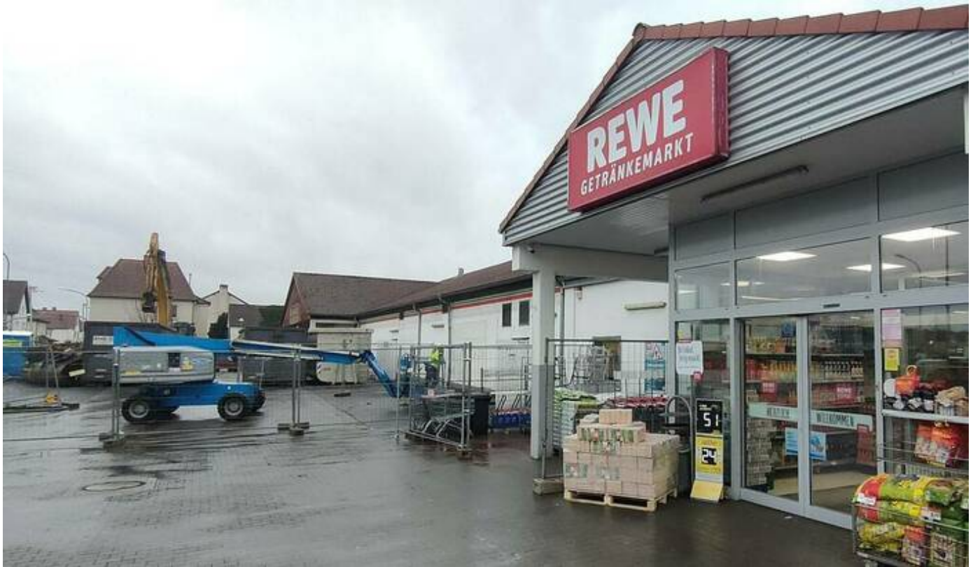
Im Getränkemarkt gibt es derzeit auch Lebensmittel. Das alte Gebäude daneben weicht aktuell den Parkplätzen für den neuen Supermarkt.
