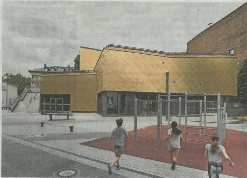
Begehbare Dach: Die Sporthalle der Schillerschule ist preiswürdig. Foto Meike Hansen
