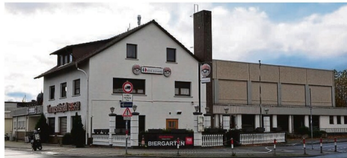
Künftige Baustelle: Die neue Sport- und Wettkampfhalle als Ersatz für die in die Jahre gekommene TGS-Halle am der Grabenstraße (Foto) soll Seligenstädts Bürgermeister nächstes Jahr vollständig planen lassen.
