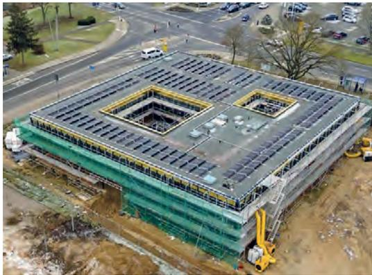
Das neue Hainburger Rathaus wird mit modernster Energietechnik ausgestattet, die gesamte Dachfläche des Rathauses ist mit einer Photovoltaikanlage versehen. Die Nennleistung dieser Anlage ist mit rd. 60 kWp angegeben und ist dafür ausgelegt, die komplette Stromversorgung des Rathauses sowie die zwei Luftwärmepumpen zur Speisung der Fußbodenheizung abzudecken. Überschüssige Energie aus der Photovoltaikanlage wird im Batteriespeicher mit einer Nennkapazität von 84 kWh gespeichert.
